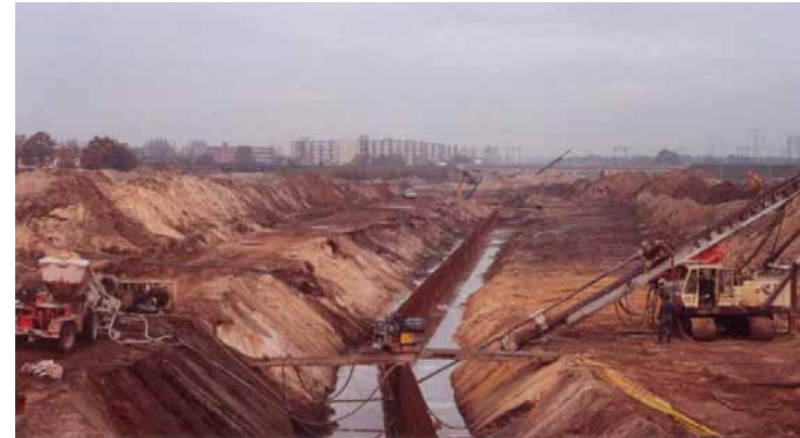
De werkzaamheden ten bate van de kanaalomleiding zijn in november 1989 in volle gang. (Particuliere collectie)
